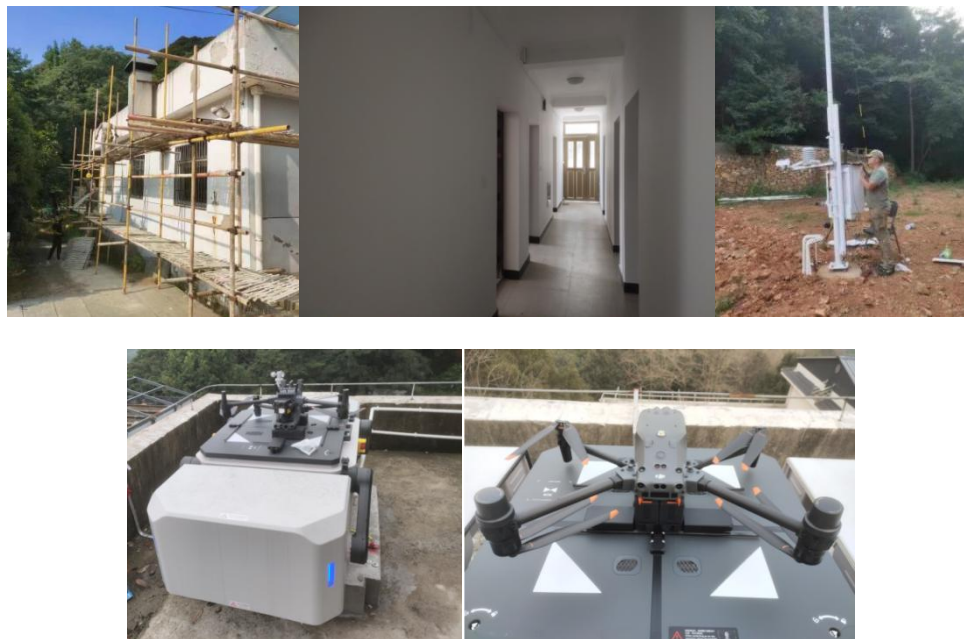
图3 台站建设现场
